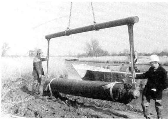
برای ثابت نمودن رُتُوتکس تایله بر روی کناره های فرسایش یافته (به منظور استقرار مجدد نی ها) ممکن است نیاز به استفاده از ماشین آلات باشد.
